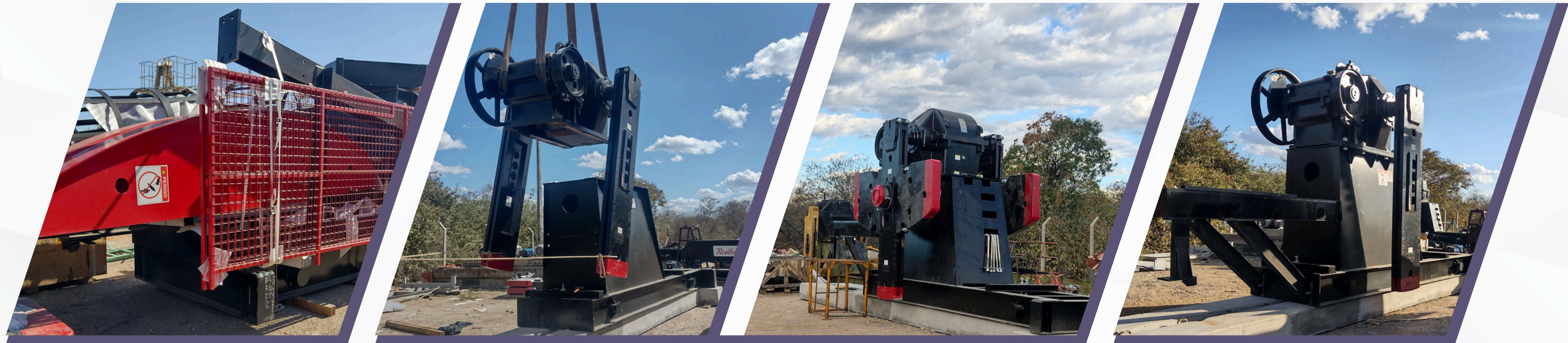
Etapas de pré-montagem de UB
