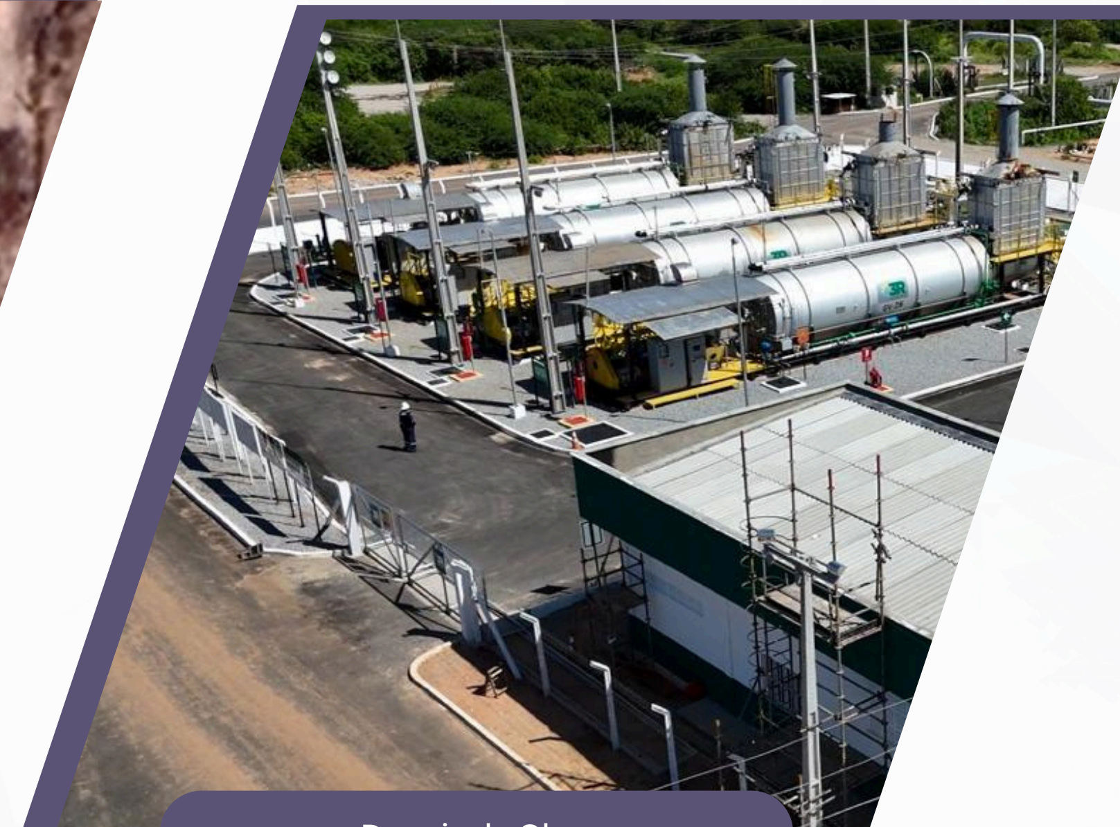
Depois da Obra
