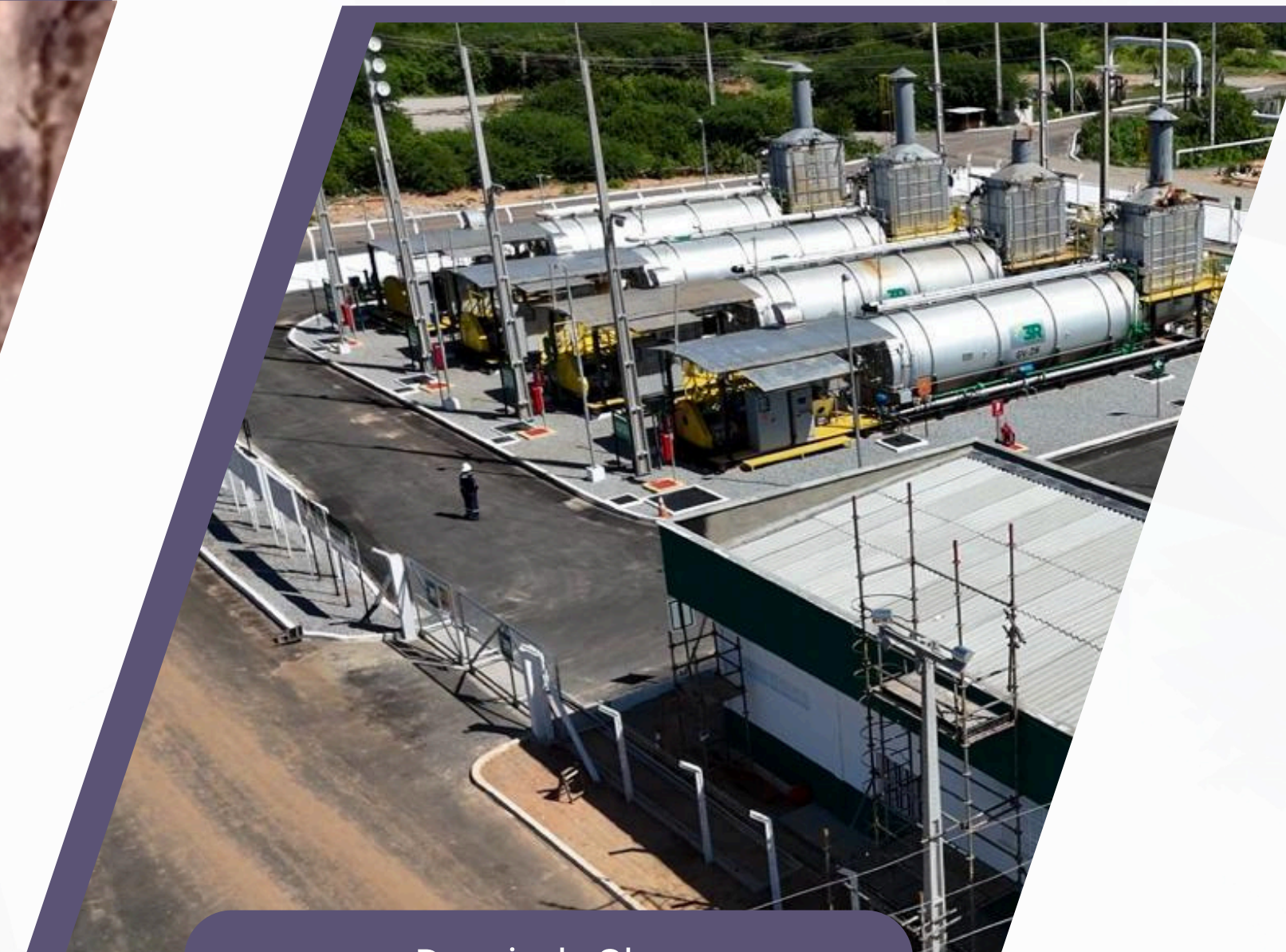
Depois da Obra
